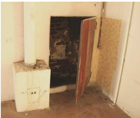
Obr. 24: Otvor do komína ve stěně 2.08a (foto 2018).
