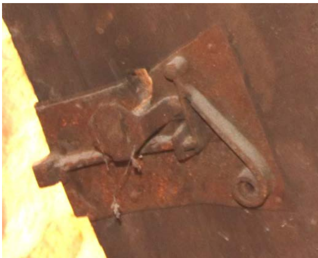
Obr. 32: Detail zřejmě gotického zámku na dveřích D4. Pohled z místnosti S.08 (foto 2018).
