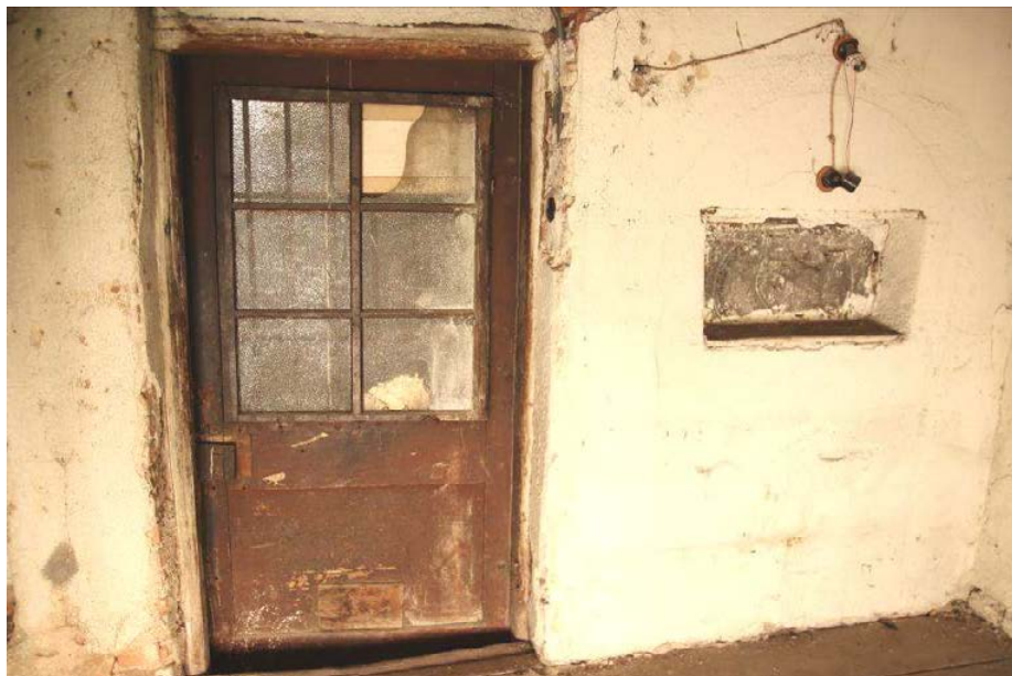
Obr. 33: Vlevo dveře D12, vpravo okenní otvor O17. Pohled z místnosti M.02 (foto 2018).
