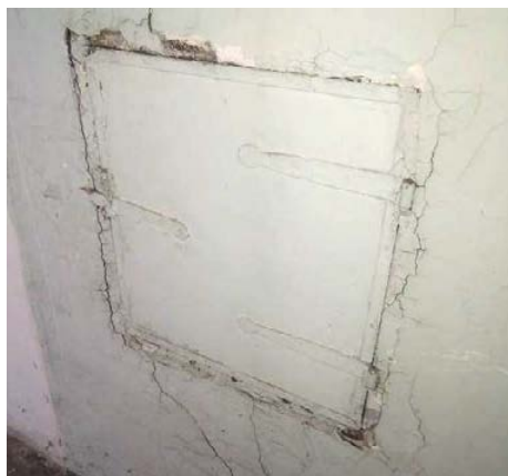
Obr. 22: Detail dvířek do komína ve stěně 1.09a (foto 2018).
