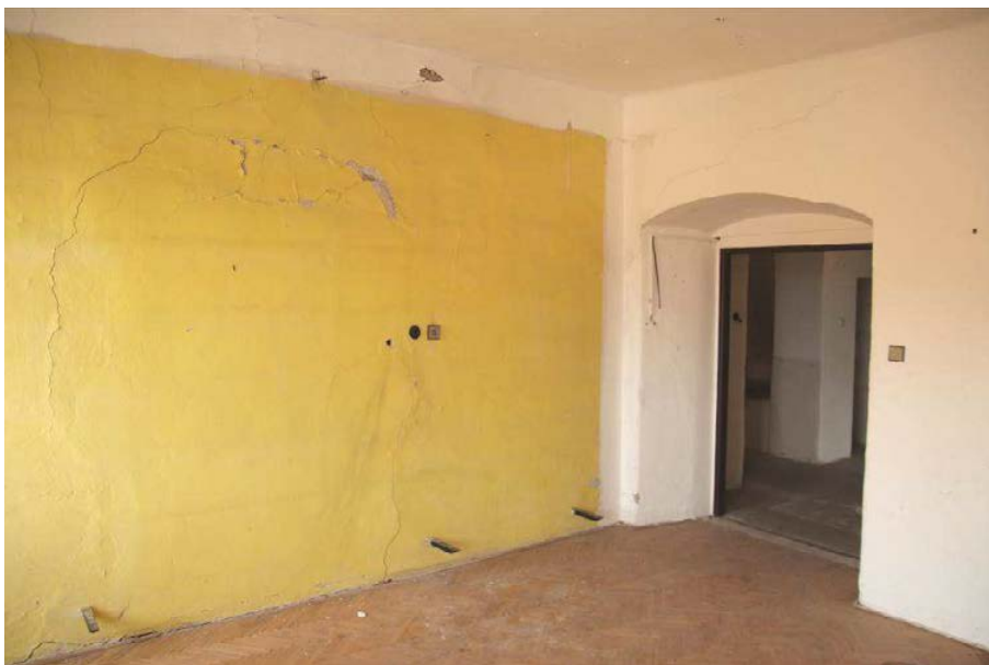
Obr. 23: Stěna 2.04 b (foto 2018). V levé části ukázka identifikace zazděného otvoru. Popraskání povrchu je způsobeno různými fyzikálními vlastnostmi staršího zdiva a zazdívkou. V pravé části dveřní otvor D35 ve stěně 2.04 c .
