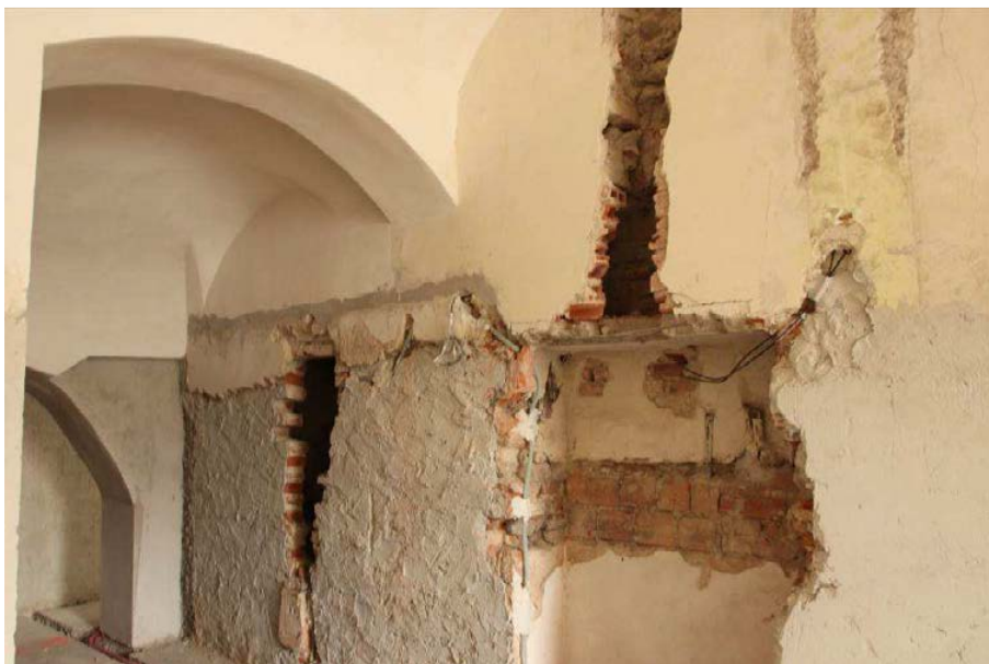
Obr. 19n20: Pohled na stěnu P.04a (foto 2018). V pravé části je nika s patrným segmentovým záklenkem nad mladším překladem. V levé části je probouraný otvor do komína. Zcela vlevo je klenební pas do místnosti P.05.
