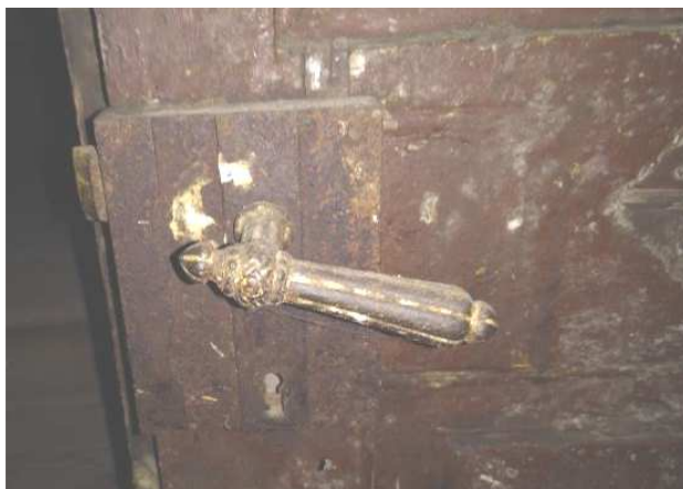
Obr. 34: Detail kliky a krabicového zámku dveří D13. Pohled z místnosti M.03 (foto 2018).
