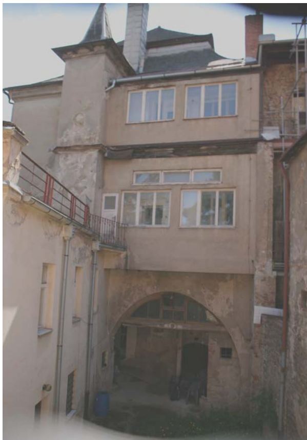
Obr. 12: Pohled na severovýchodní průčelí (foto 2017). Vlevo je dvorní křídlo, na kterém stojí rizalit. Uprostřed je klenební pas otevřený do průjezdu, nad ním pavlače 1. a 2. patra.
