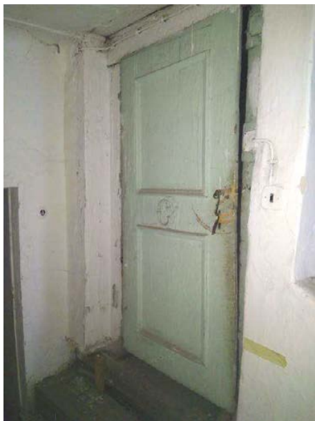
Obr. 35: Dveře D42. Pohled z místnosti 2.08 (foto 2018).
