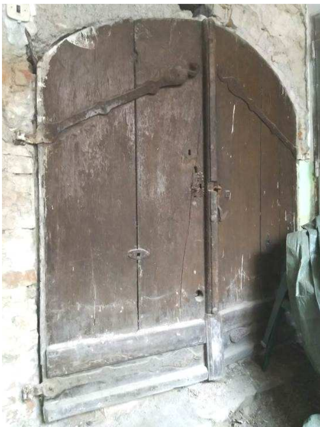
Obr. 30: Dveře D3. Pohled z průjezdu (foto 2018).
