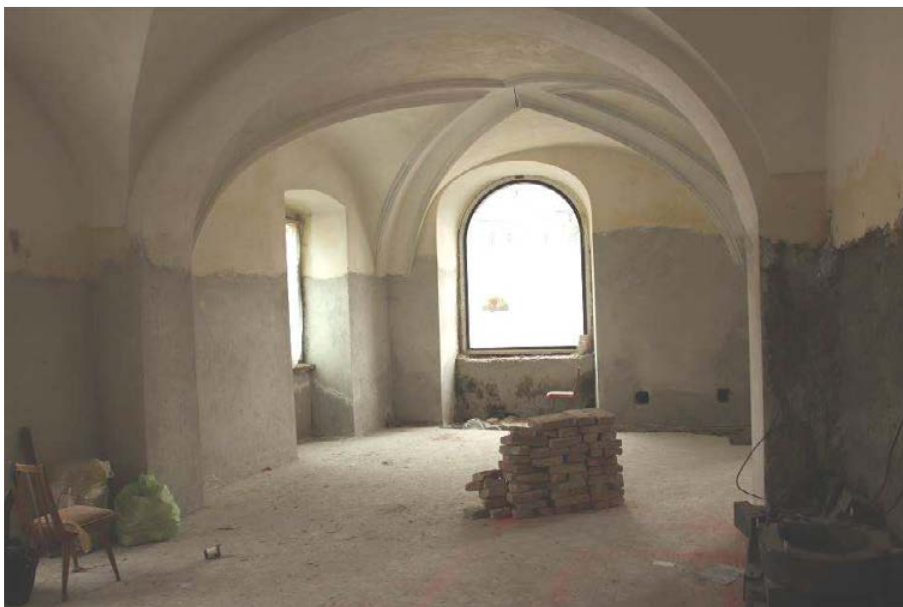
Obr. 19: Pohled do místnosti P.01 skrz místnost P.02. Místnost P.01 je zaklenuta klášterní klenbou prolomenou trojbokými výsečemi (foto 2018).
