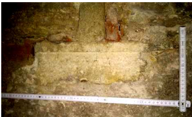
Obr. 17: Stěna S.03a, detail druhotně užitého kamenicky opracovaného ostění (foto 2018).
