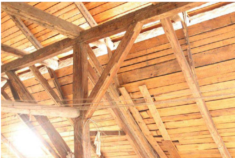
Obr. 25: Detail prostřední plně vazby, jihovýchodní strana (foto 2018).
