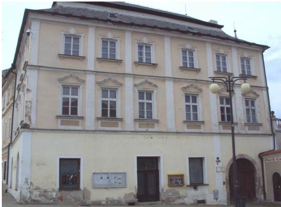
Obr. 38: Jihovýchodní průčelí domu čp. 379 (foto 2020).
