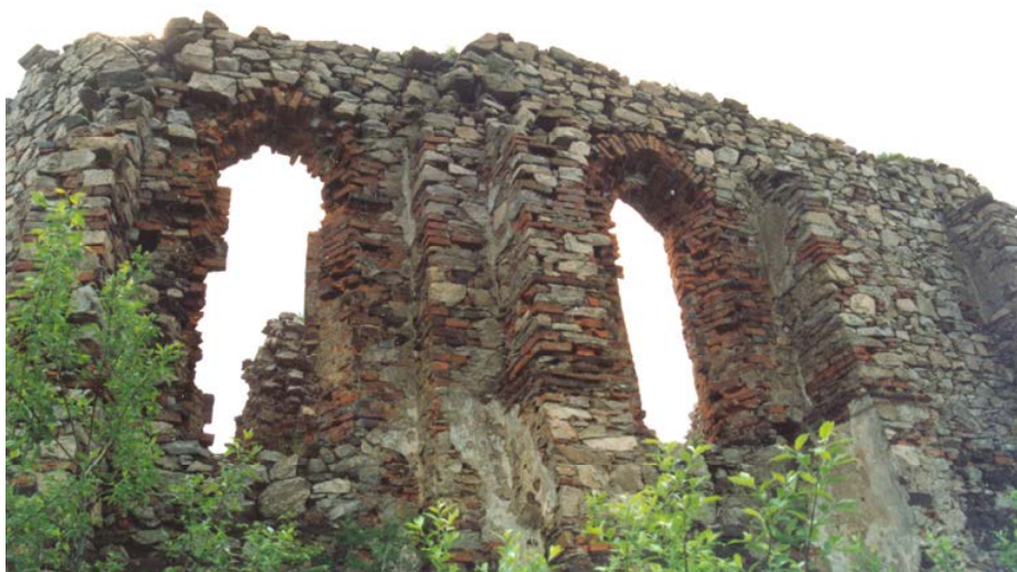
Vlastějovice, zřícenina kaple na Fiolníku od severu (květen 1996)
