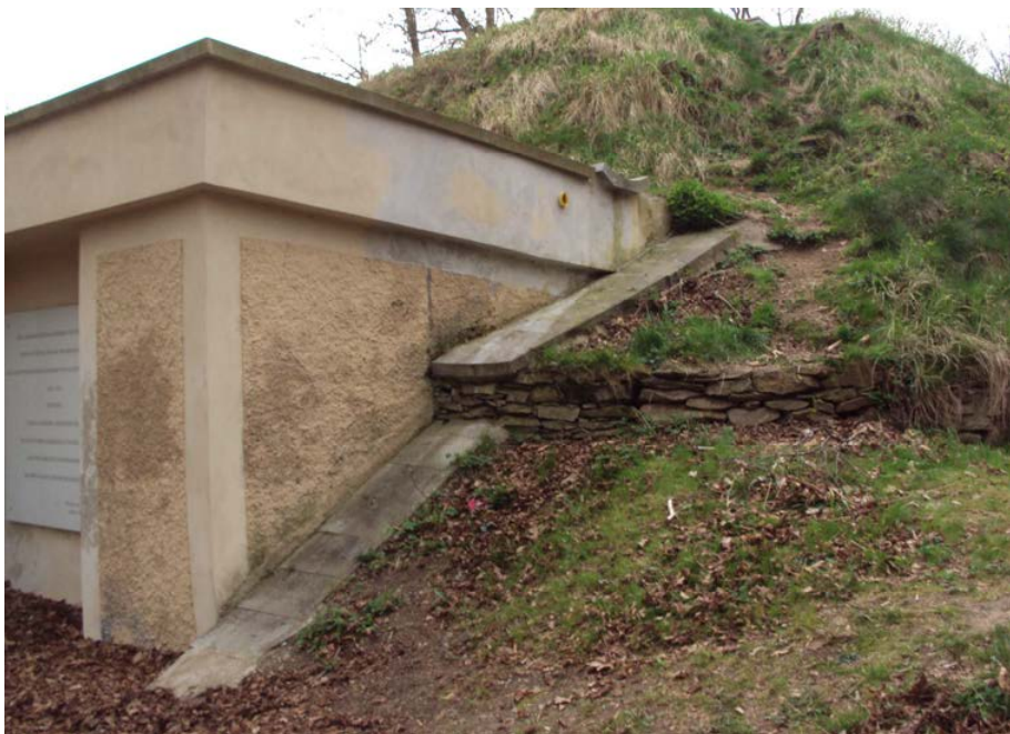
Kalvárie na Kaňku, severní boční stěna průčelí památníku s navazujícím úsekem kamenné zdi obíhající mohyly (foto 4/2014). Svah v popředí je pozůstatkem po obloukovitých kamenných zdech rámuujících prostor před průčelím.
