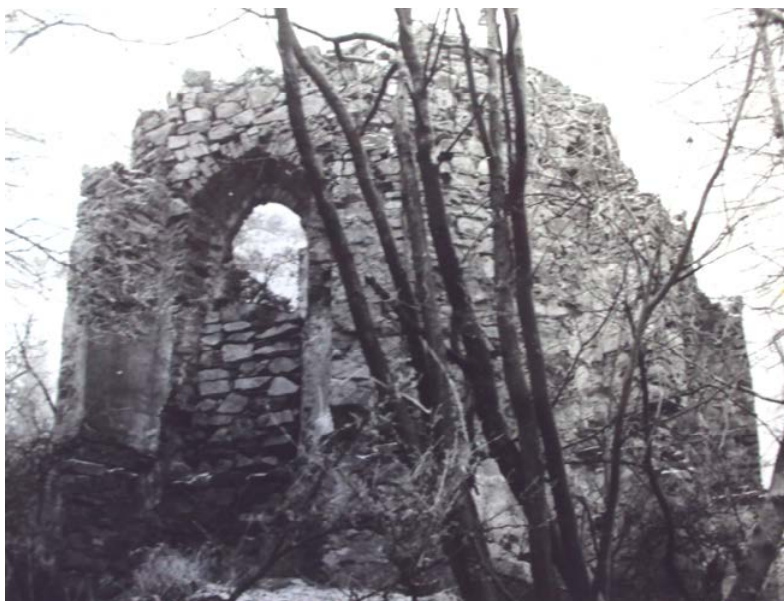
Vlastějovice, kaple na Fiolníku se zazdívkou východního okna (SOKA KH).
