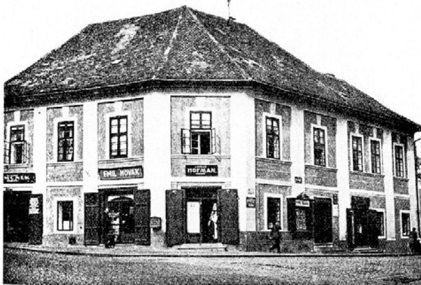
Obr. 3. Dům čp. 409 na nároží Tylovy a Palackého náměstí (správně ul. Tylovy a Na Náměti) Dobře udržovaný.
