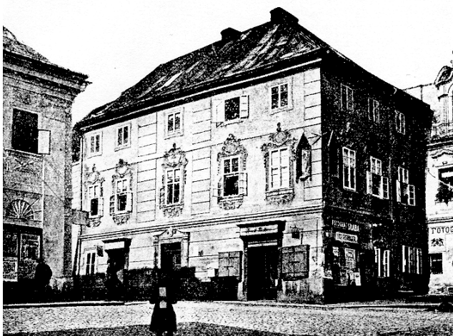
Obr. 1. Dům čp. 141 v Husově třídě, přestavěný barokně po požáru 1736. Nyní dobře udržován.
