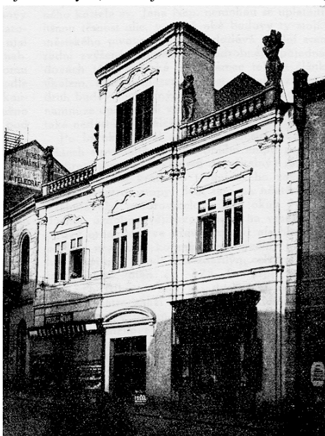
Obr. 2. Dům čp. 152 v Husově třídě, přestavěný na počátku XVIII. stol. Nyní výborně (v omítkě i plastikách) konservován.
