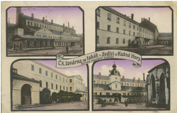
Někdy se na pohlednicích objevily i chybné názvy, jako je to v případě nápisu u C. K. továrny na tabák v Sedlci u Kutné Hory. Označení „Bývalý jezuitský klášter“ je chybné – klášter byl cisterciácký. (in. č. PO/892)
