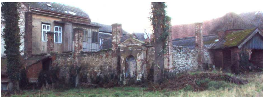
Kaplička Panny Marie na zahradě u domu čp. 261 v Hradební ulici. Vpravo je dům čp. 260 v Orelské ulici, k opěrné zdi jeho zahrádky je kaplička přistavěna (prosinec 2016).
