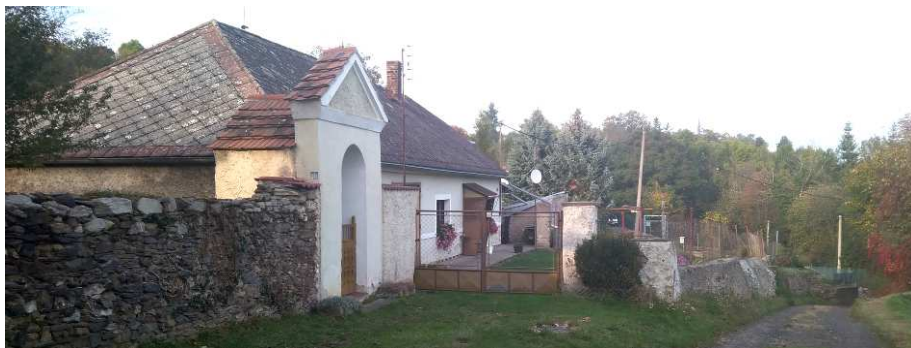
Dolní Žižkov, kaplička Panny Marie nad Bylankou v ulici U Trojice (říjen 2020).
