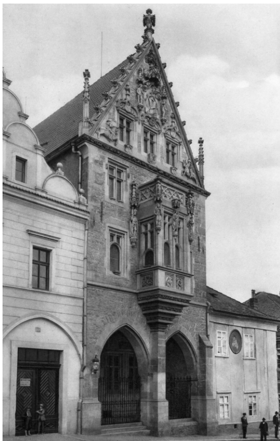
Kamenný dům po restauraci.
