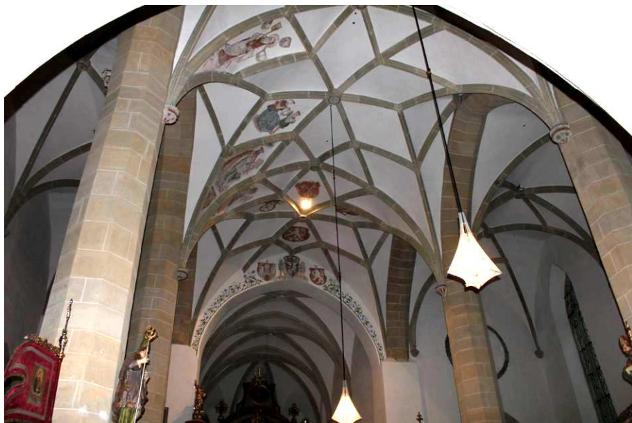
28. Čáslav, kostel sv. Petra a Pavla, síťová klenba hlavní lodi trojlodí. Foto: autor.
