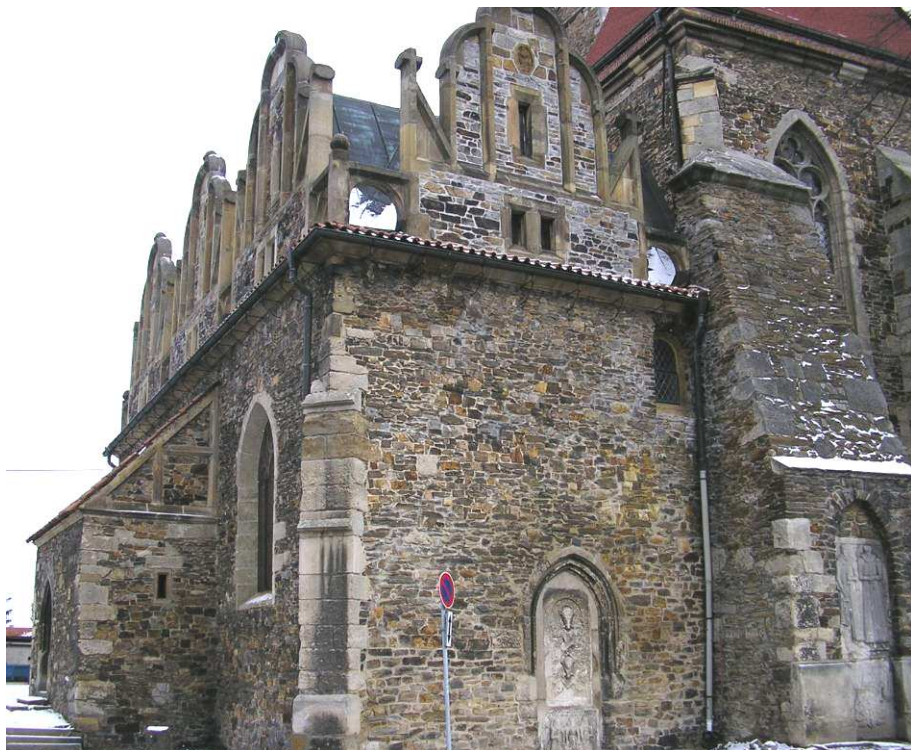
15. Čáslav, kostel sv. Petra a Pavla, severozápadní nároží severní přístavby. Foto: autor.
