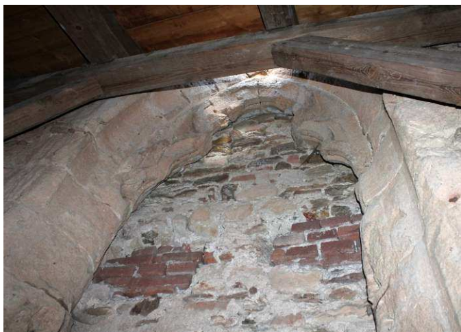
8. Čáslav, kostel sv. Petra a Pavla, zazděné původní okno severního průčelí trojlodí. Foto: autor.
