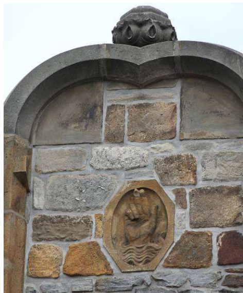
16. Čáslav, kostel sv. Petra a Pavla, detail štítu západního průčelí severní přístavby. Foto: autor.
