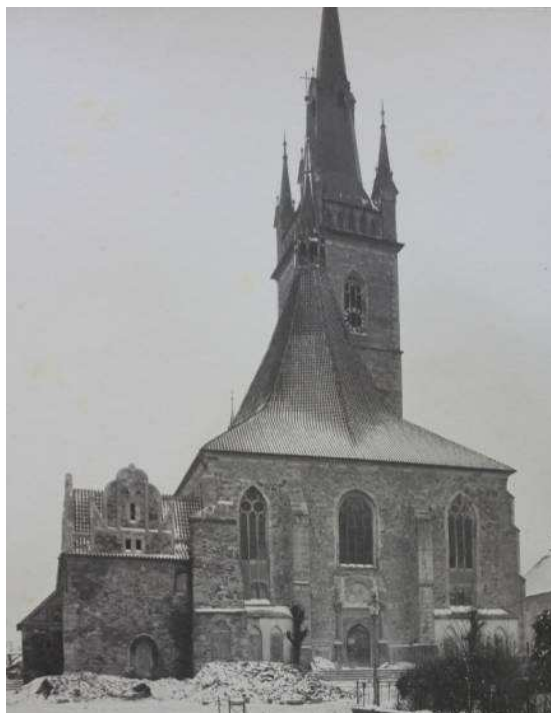
3. Čáslav, Kostel sv. Petra a Pavla po restauraci, pohled od západu z roku 1911, J. Štenc. SOKA Kutná Hora, Sbíрка fotografií Čáslav, album fotografií kostela sv. Petra a Pavla.
