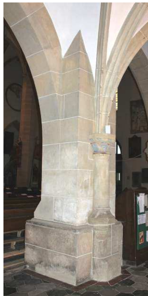
41. Čáslav, kostel sv. Petra a Pavla, severní pilíř kruchty, pohled od západní stěny trojlodí. Foto: autor.
