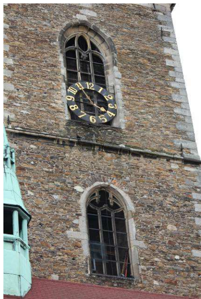
22. Čáslav, kostel sv. Petra a Pavla, okna věže, pohled od severu. Foto: autor.
