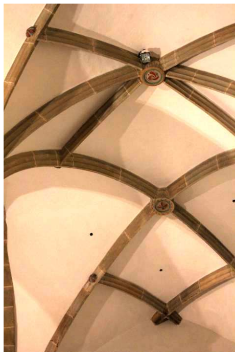
29. Čáslav, kostel sv. Petra a Pavla, křížová klenba jižní boční lodi trojlodí s přidávanými žebry. Foto: autor.
