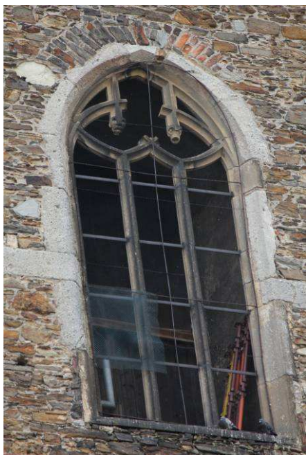
60. Čáslav, kostel sv. Petra a Pavla, detail okna severního průčelí věže. Foto: autor.
