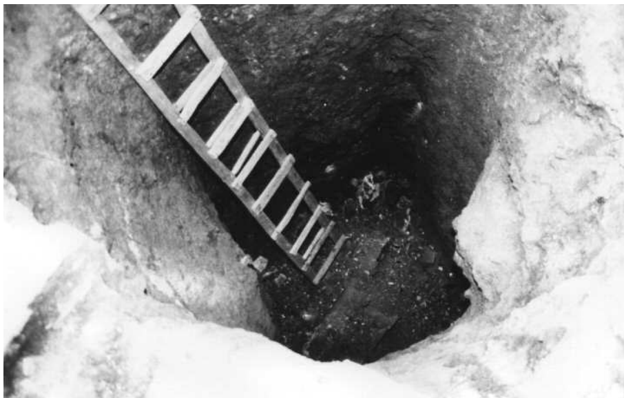
Pohled do propadu před jeho zabezpečením (19.6.1991).
