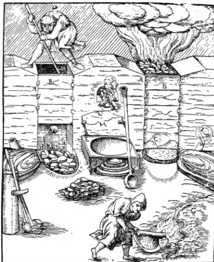
1574 - tavba olověných rud v Goslaru v kelímkové peci na lehké vyzdívce (Ercker 1974, 216; popis dle Schlütera).
