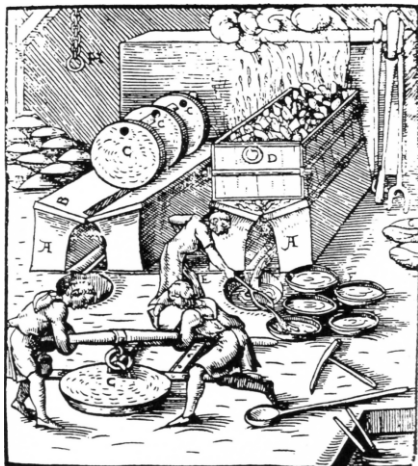
1574 - ságrovací - vycezovací pec (vycezení olova se stříbrem - vzniká cední olovo) (Ercker 1974, 197).
