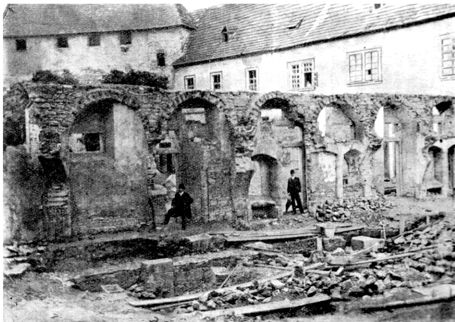
Obr. 2. Vnitřek zbořeného traktu šmiten na straně jihozápadní.
