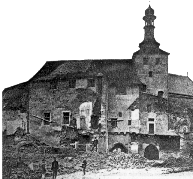
Obr. 36. Vysoký dům s věží po odbourání předních budov.
