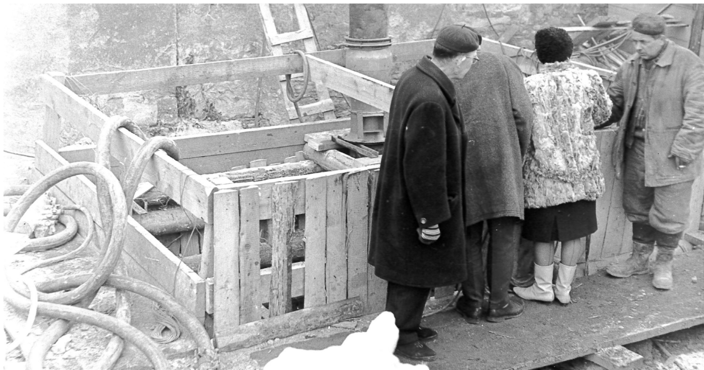
Hloubení důlní šachty u budoucího „horního trejvu“, 1968
